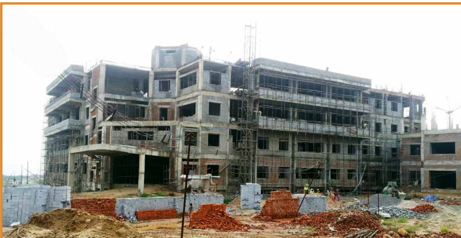
फरीदाबाद में टीएचएसटीआई प्रयोगशाला और कार्यालय निर्माणाधीन
